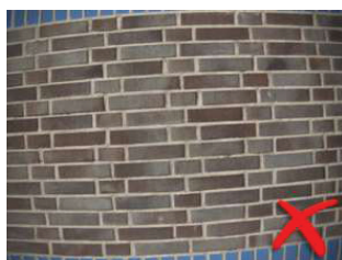
Рис. 5.10. Пример снимка камерой, объектив которой имеет сильную дисторсию
